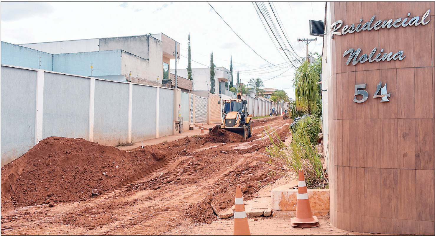
Pavimentação, drenagem urbana, meios-fios e calçadas são alguns dos serviços que serão realizados no setor habitacional
